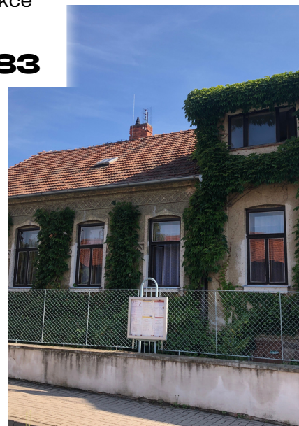
Budova před rekonstrukcí
